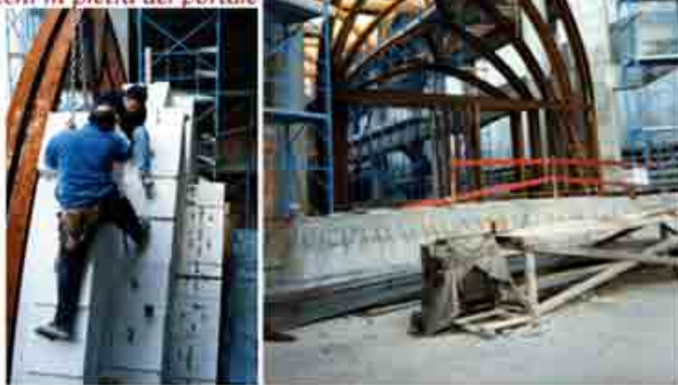
Posa dei blocchi in pietra del portale
