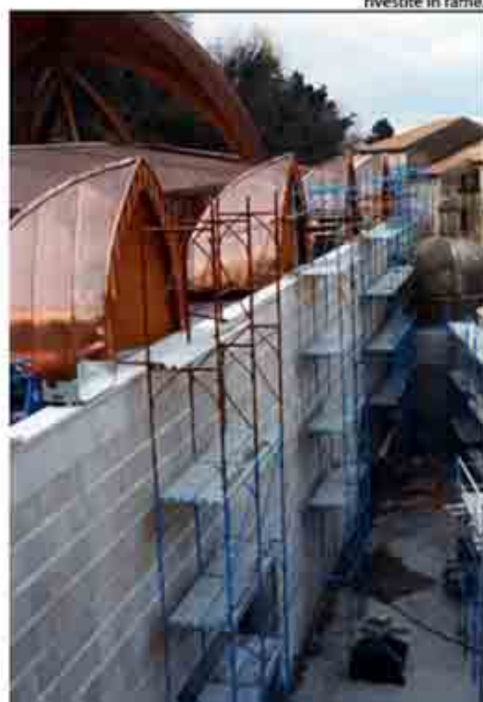
Vista della muratura esterna rivestita in pietra e delle calotte di luce rivestite in rame.
