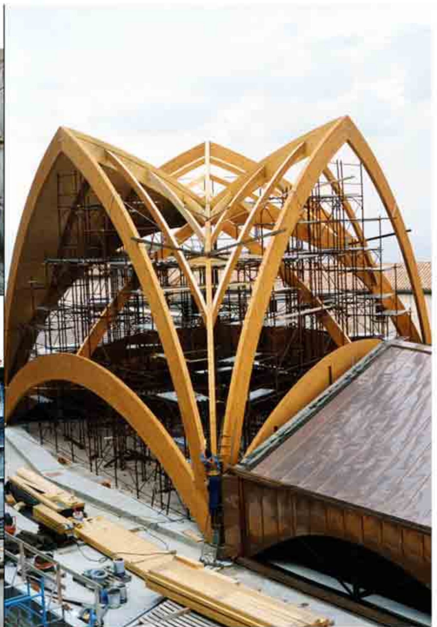
Particolare della struttura del tiburio
