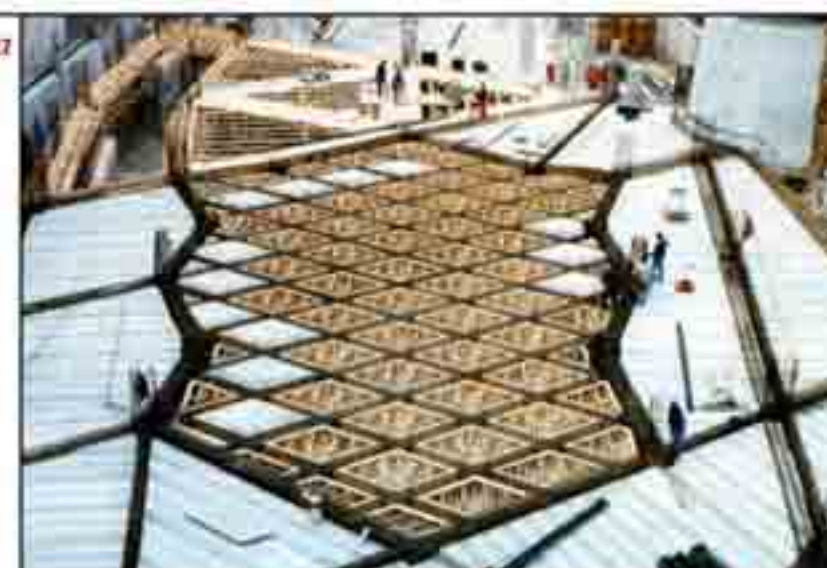
Particolare della costruzione del solaio
