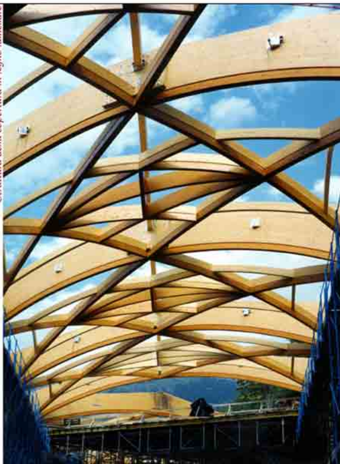
Struttura della copertura in legno lamellare
