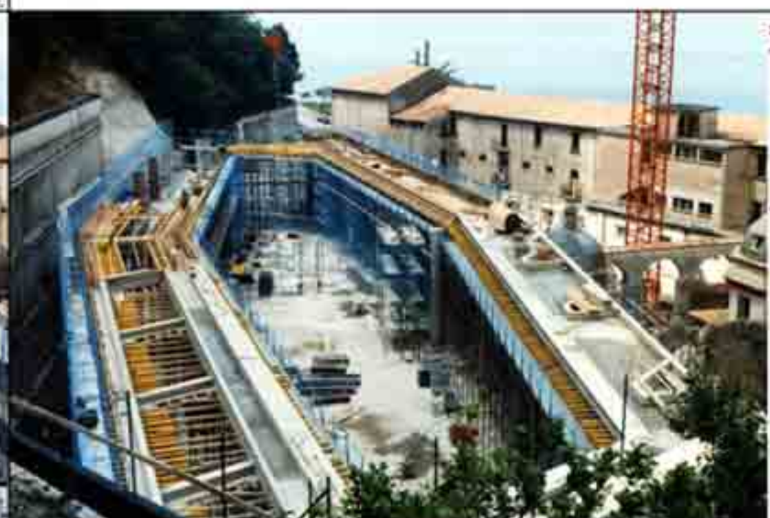
Fasi di costruzione della struttura
