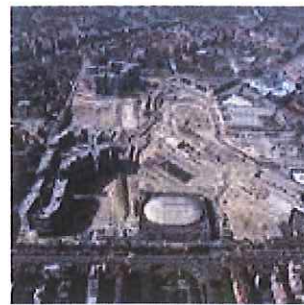
I lavori nel 2012
