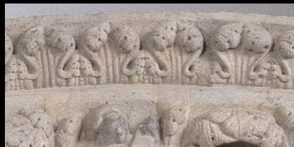
Particolare dell’architrave superiore
