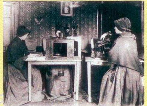
Le suore di Maria Bambina misurano le lastre del Catalogo astrografico con i micrometri Repsold
