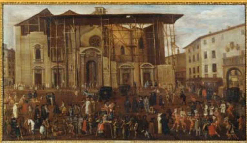
Plazza del Duomo durante il cantiere, con la facciata della Cattedrale in corso d'opera. Opera attribuita al Sebastiano.
