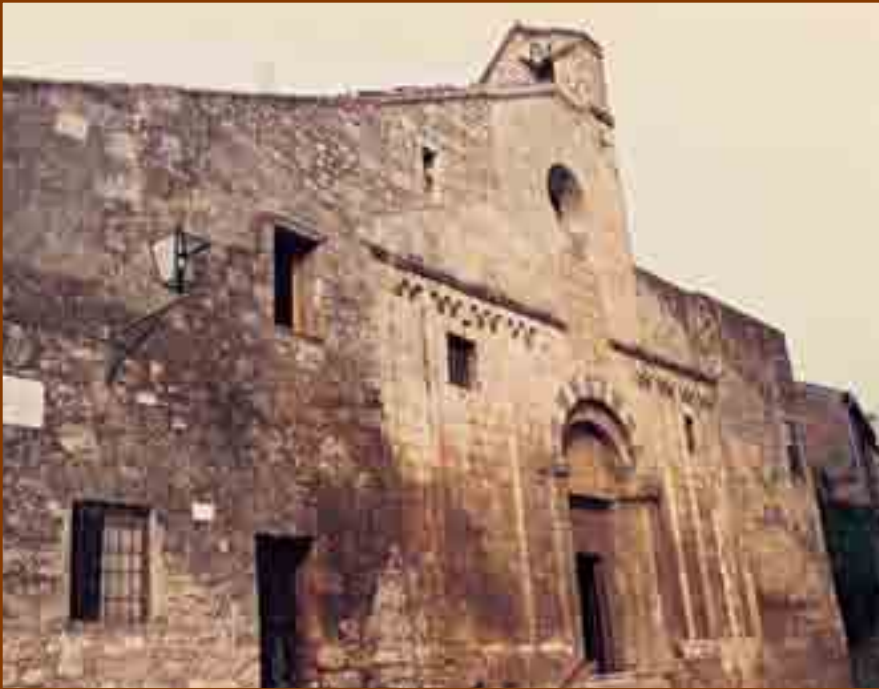
SAN MARTINO La facciata Tarquinia (VT)
