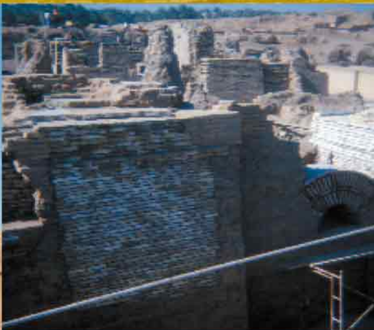
Il Palazzo di Nabucodonosor prima del restauro
