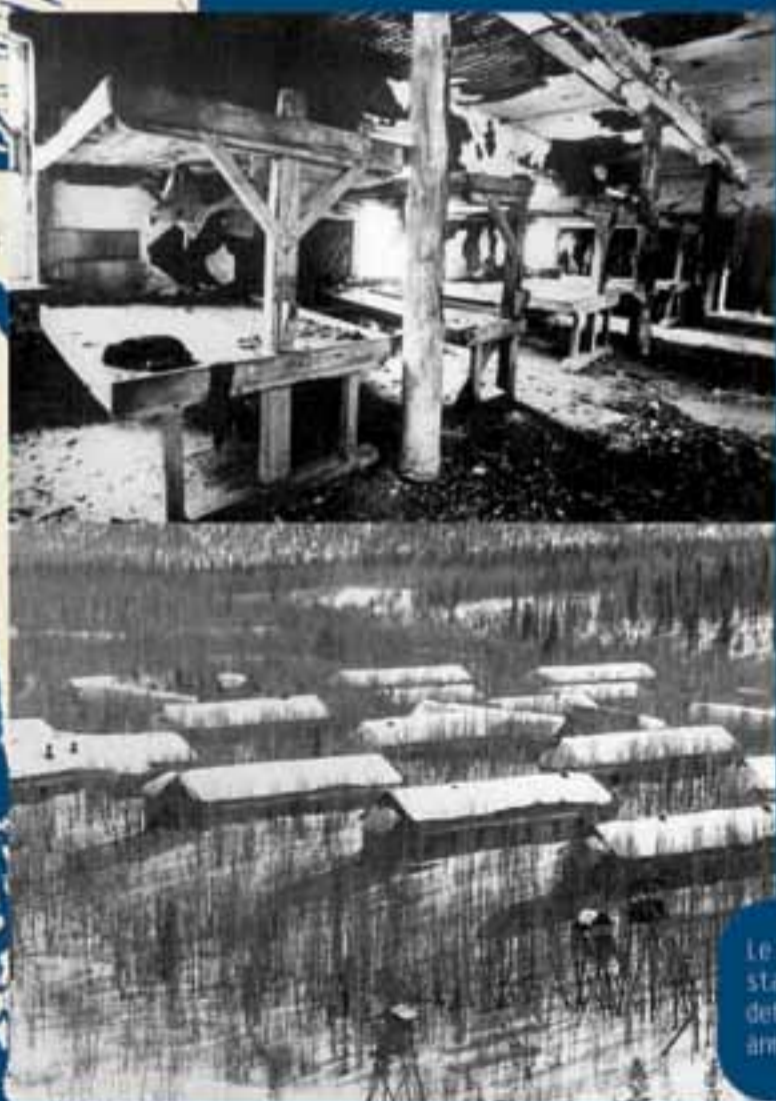
Baracca femminile del cantiere per il canale mar Bianco-mar Baltico, 1932.
